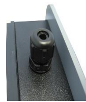
Durchführung von außen
